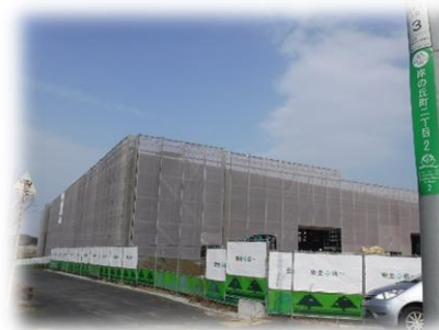
新工場建設中
