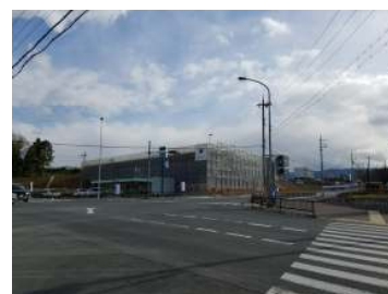
写真 建設工事の状況
