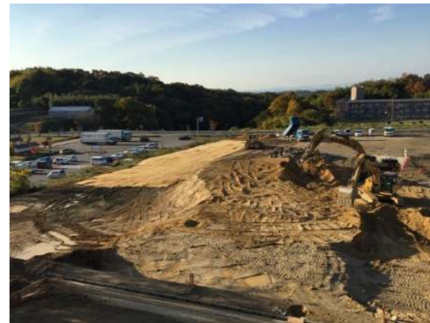
【道の駅「愛彩ランド」隣接地の造成工事】
