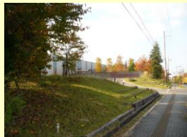
■緑化された法面のイメージ
