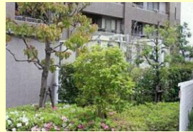
■屋外設備を緑化により目立たなくした工夫
