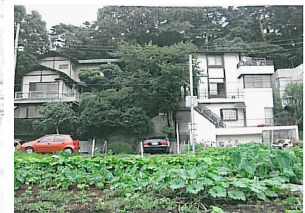
傾斜地住宅と前面の農園
